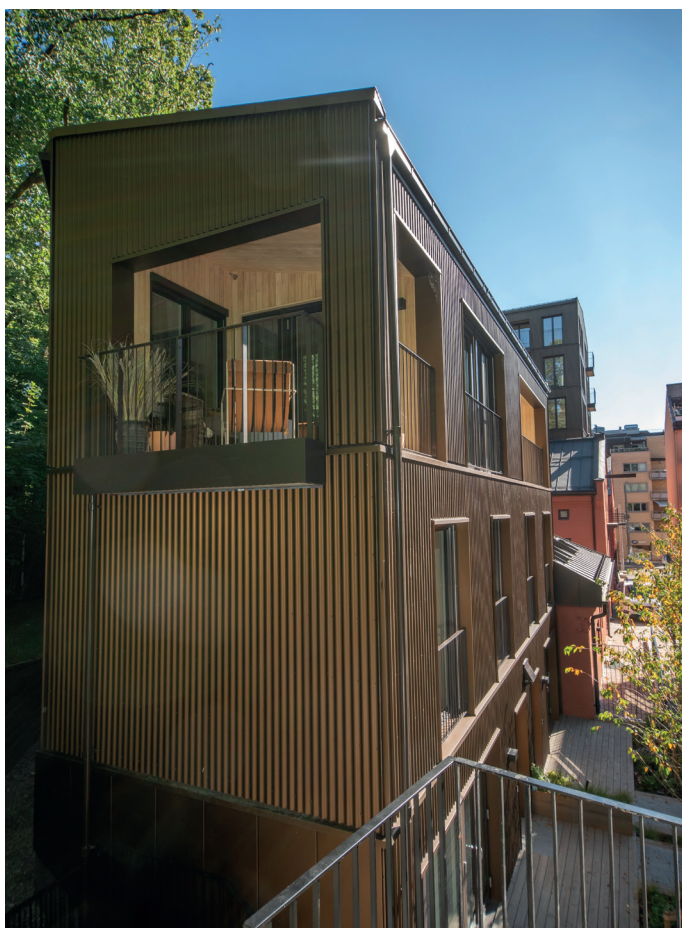
De nye bygget i kvartalet har fått fasader kledd i bronseeloksert aluminium.
