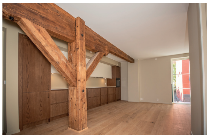
Flere deler av den gamle bærekonstruksjonen er bevart og løftet frem i de rehabiliterte arealene.
